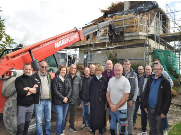
> Visite chantier couverture chaume de l'entreprise FERRERO (11 octobre 2024)
