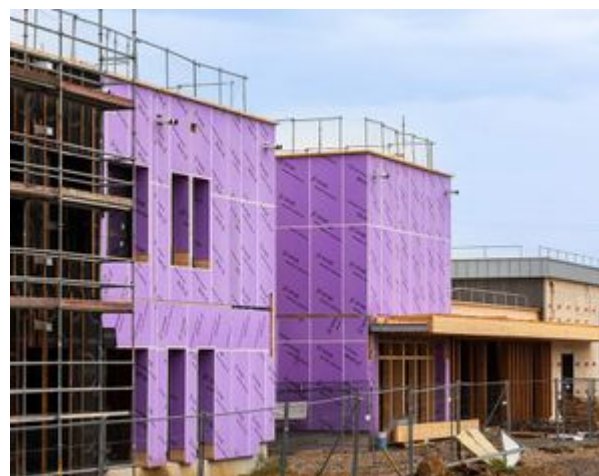
Defentex : chantier de Montbéliard-Nord Bethoncourt, 25
