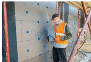
Depuis le 1<sup>er</sup> janvier, la résistance thermique R exigée pour les travaux d'isolation thermique par l'extérieur (ITE) des murs en façade ou en pignon est passée à 4.40 m2. K/W minimum (au lieu de 3,70) uniquement dans le cadre d'une rénovation globale (demande d'aide pour MaPrimeRénov' Parcours
